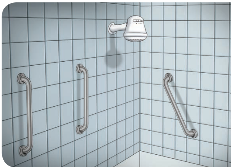
Presença de barras de apoio em áreas molhadas
