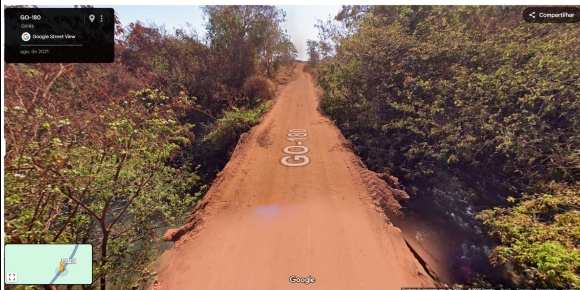
Figura 2: Imagem Street View Google Earth, ago/2021 – Ponte existente sobre o Rio Ribeirão da Felicidade.
